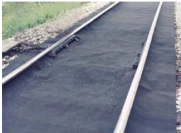
1. kép Olajfogó paplan vágányban (Hunyár Á. at. all. 2002)
