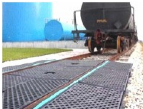
2. kép Vasúti gyűjtőtálca (Hunyár Á. at. all. 2002)
